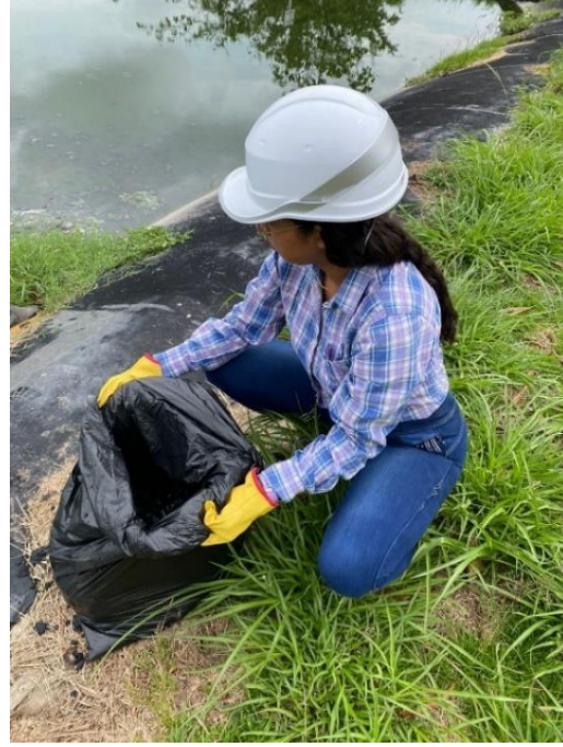
Recolección de lodos de PTAR
