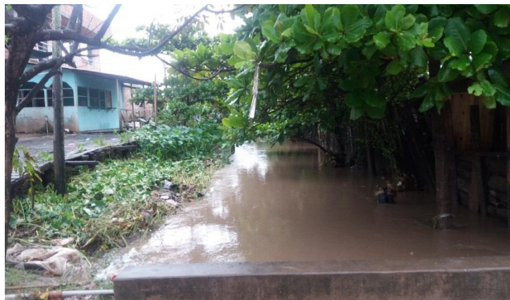
Figura 42. Estación III-1 del caño natural “Unión”, luego de una lluvia moderada. Pucallpa, 2018.
