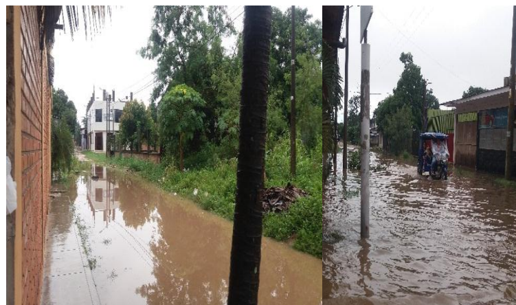
Figura 24. Estación I-1 del caño natural "Yumantay" y calle paralelo a la estación, luego de una lluvia moderada. Pucallpa, 2018.
