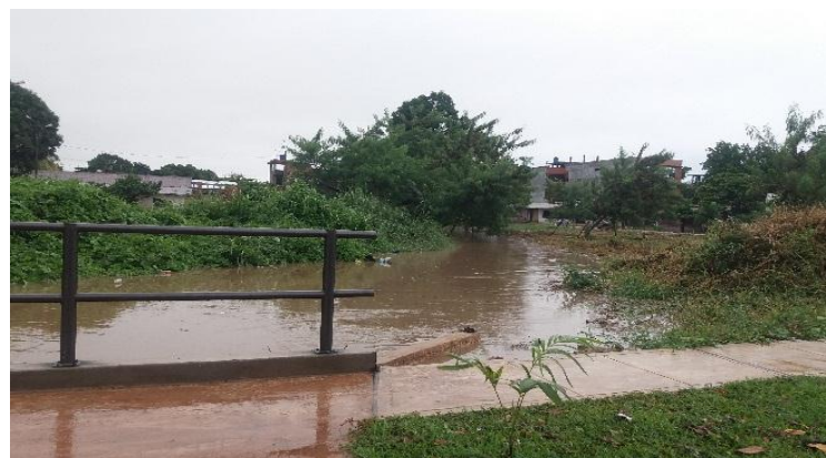
Figura 27. Estación I-2 del caño natural "Yumantay", luego de una lluvia moderada. Pucallpa, 2018.
