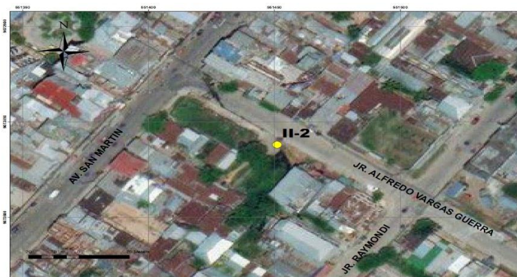
Figura 34. Vista aérea de la Estación II-2 del caño natural "Asnacaño". Pucallpa, 2018.
