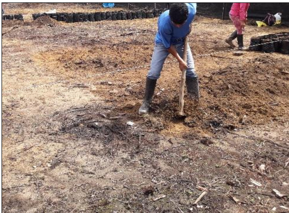
Figura 9A. Nivelación y preparación de sustrato para llenado.
