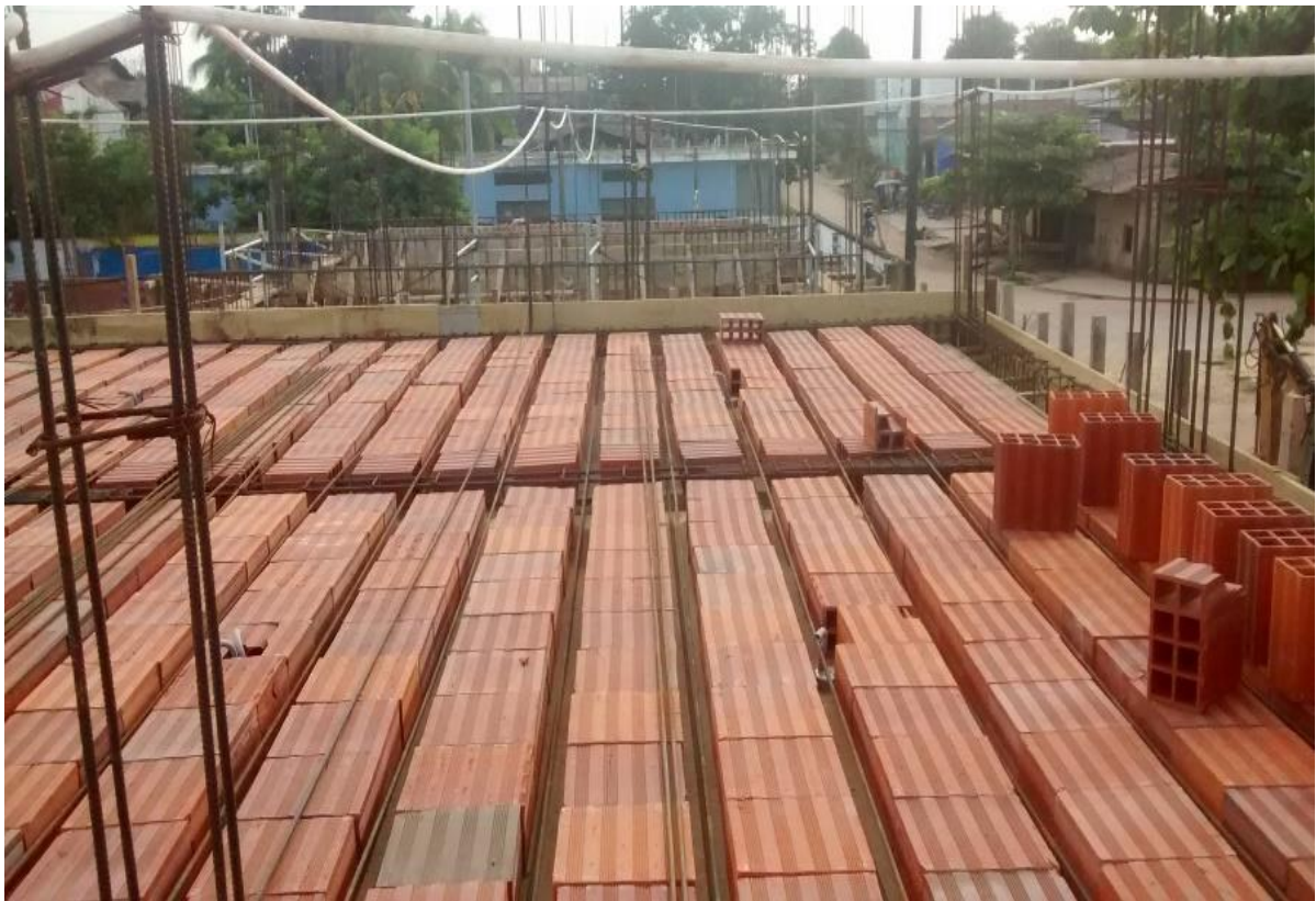
LOSA ALIGERADA DE LA INSTITUCION EDUCATIVA ABNER MONROY
