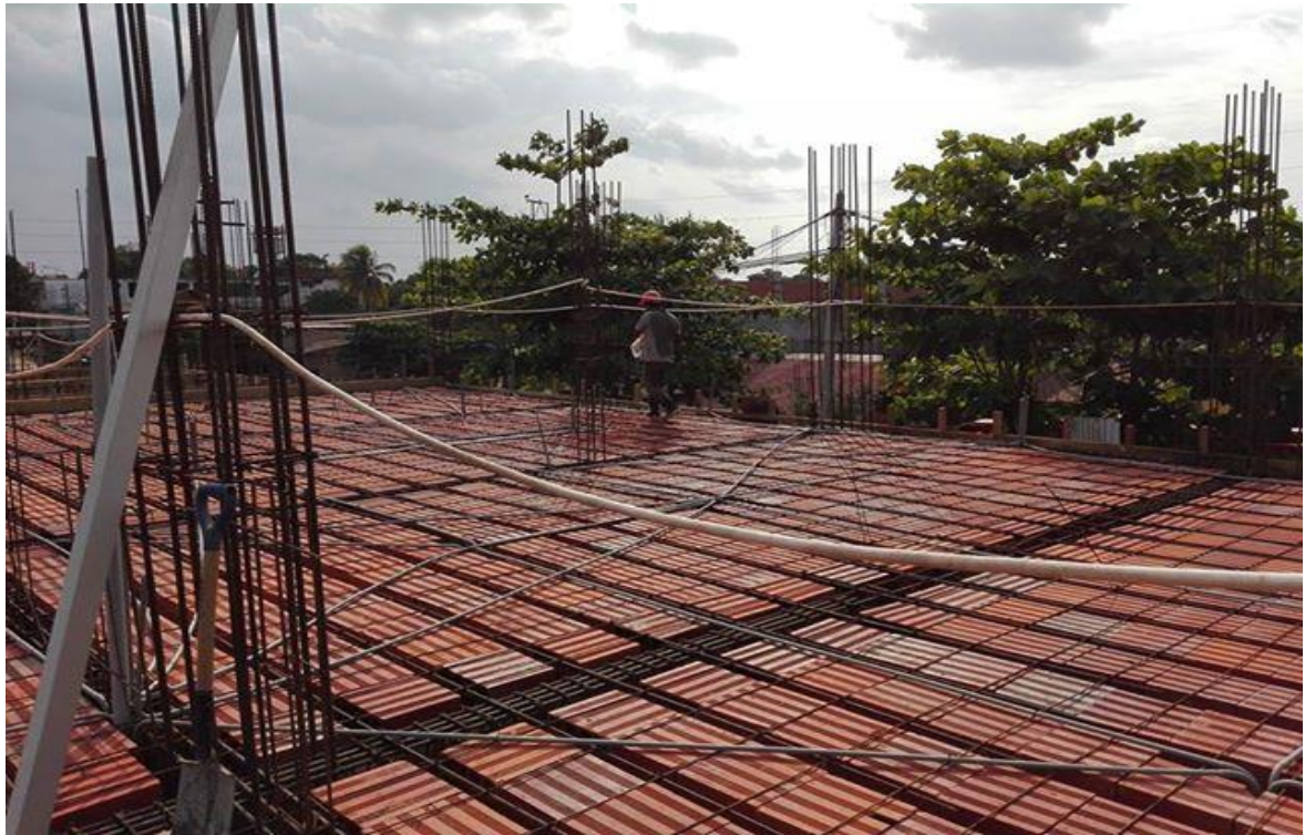
LOSA ALIGERADA DE LA INSTITUCION EDUCATIVA ABNER MONROY
