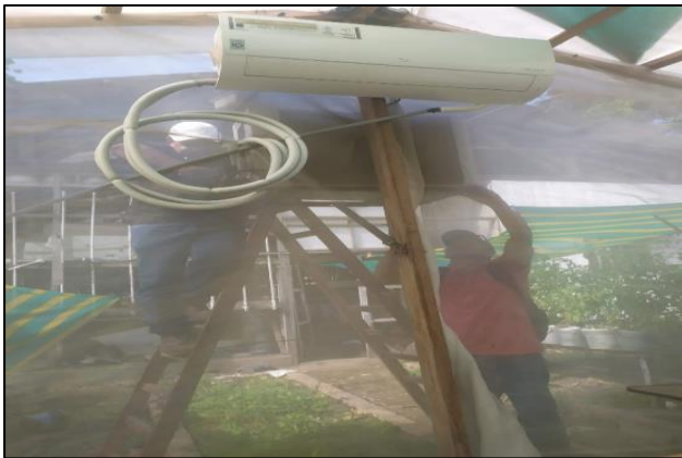
Figura 9A. Instalación del equipo de aire acondicionado.
