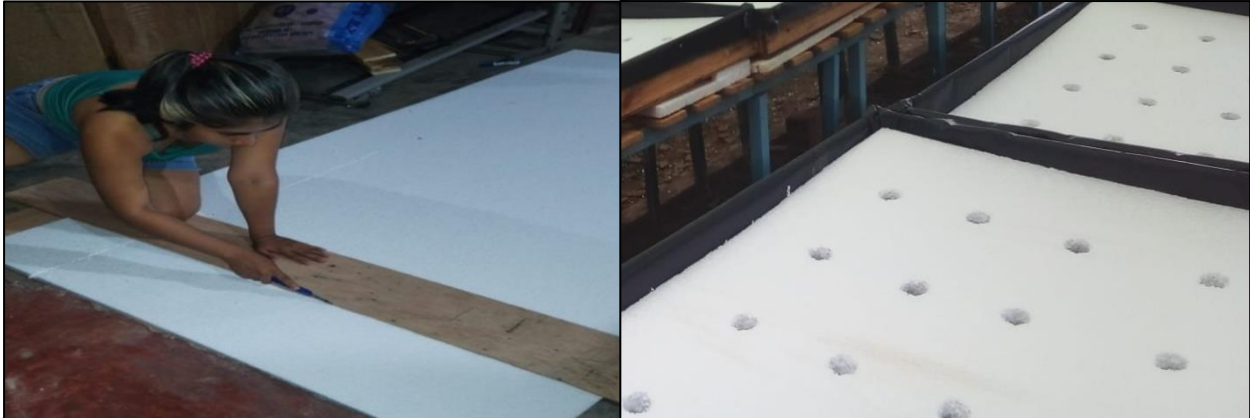
Figura 8A. Medición y perforación del tecnopor.
