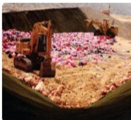
RELLENO DE SEGURIDAD
